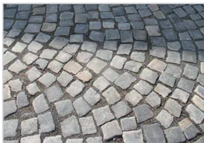
Abbildung 8: Fehlerhafter Pflasterverbund
