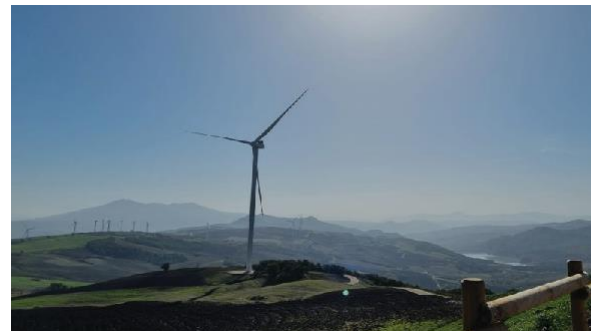
SERRALONGA ENERGIA S.R.L
